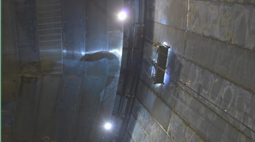
en espace confiné ont nécessité la prise de mesures de sécurité spéciales : le port d'une cagoule ventilée pour chaque soudeur et la pose d'un système de ventilation générale assurant un renouvellement d'air adapté.
