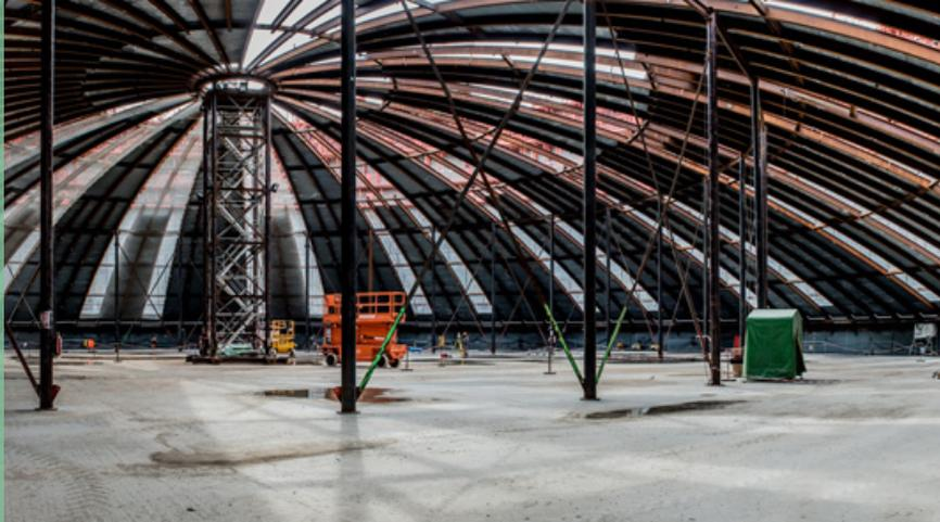
39 280 m<sup>3</sup>, c'est le volume de béton fabriqué sur place et coulé pour réaliser les parois béton extérieures des 3 réservoirs du terminal, d'une hauteur d'environ 36 m, 80 cm d'épaisseur et d'une circonférence d'environ 290 m chacun.
