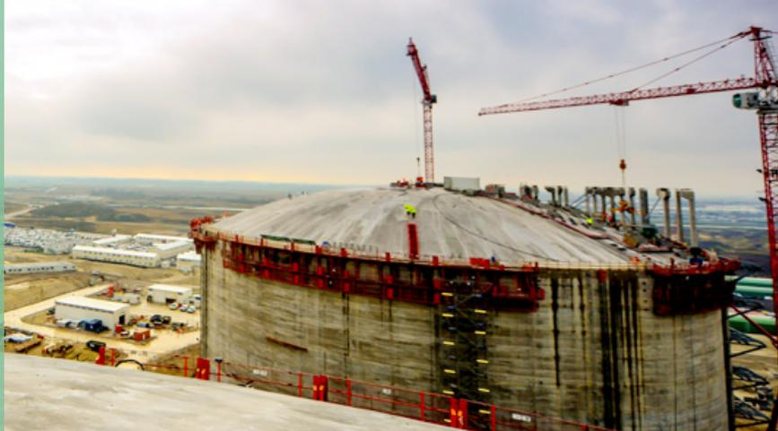
passer la main à une autre entreprise pour la suite des travaux. Cette phase de la construction du « bâtiment compresseurs » devrait être terminée en septembre 2014. Les compresseurs, eux arriveront au printemps 2014. Sur le terminal en activité, ils serviront à comprimer le gaz évaporé dans les réservoirs pour le réincorporer sous forme liquide, ou pour l'envoyer sous pression sur le réseau de transport.
